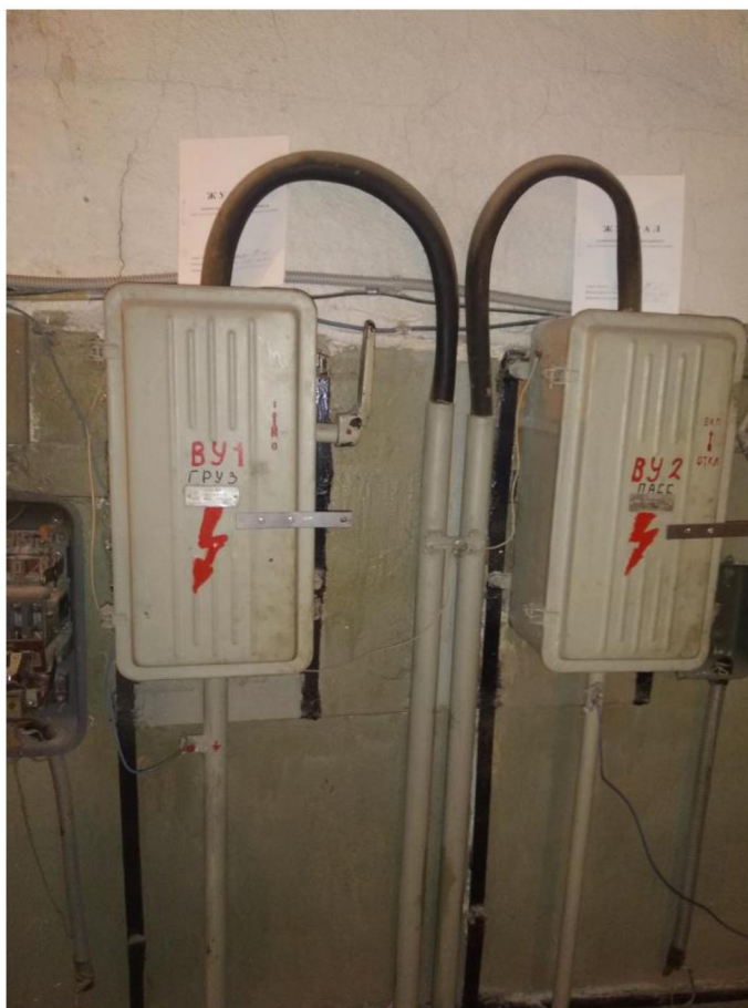
Рисунок 7 – Вводное устройство
