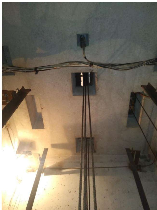
Рисунок 3 – Плита перекрытия шахты
