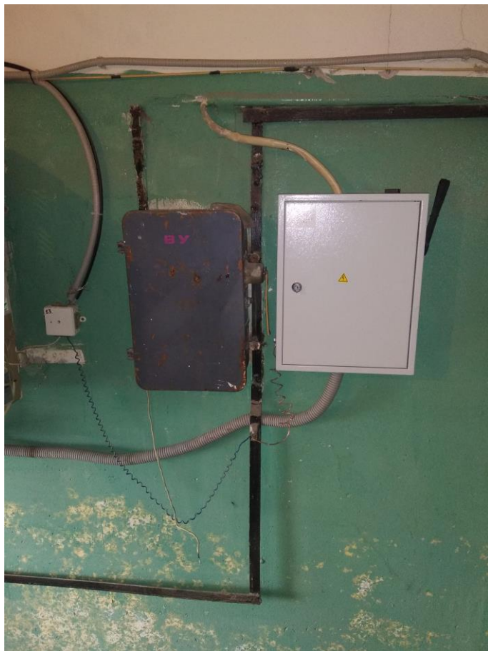
Рисунок 7 – Вводное устройство
