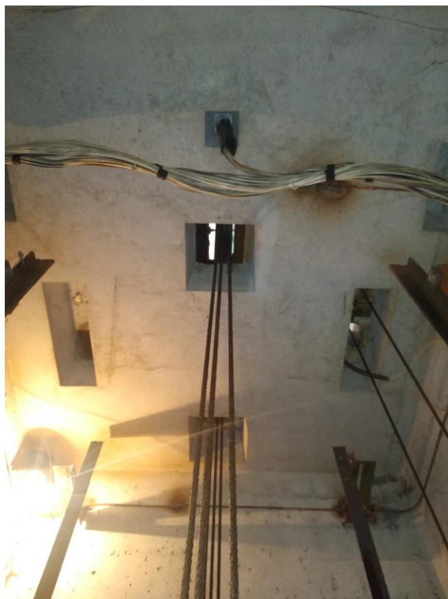
Рисунок 3 – Плита перекрытия шахты
