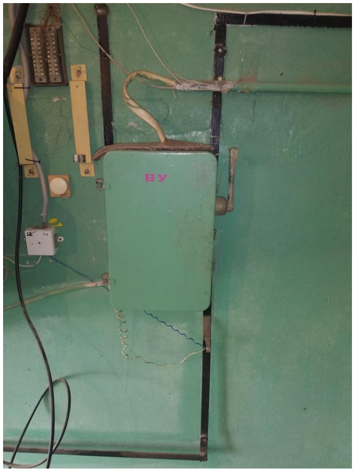
Рисунок 7 – Вводное устройство
